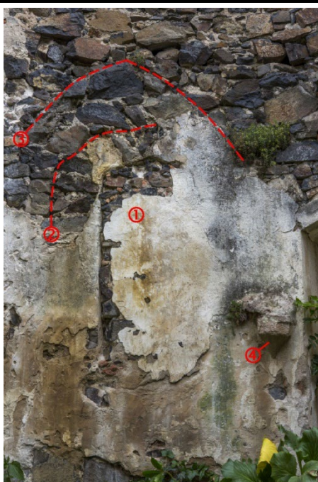
Detail zazděného severovýchodního okenního otvoru presbytáře v pohledu od západu. 1) zazděný okenní otvor, 2) nepravidelná spojitá linie oddělující charakterově odlišné zdivo dokládající patrně mladší realizaci otvoru 1 namísto staršího, 3) linie ustupujícího zdiva klenebního čela, 4) dochovaná severovýchodní klenební konzole. Foto: Marta Pavlíková 2019.
