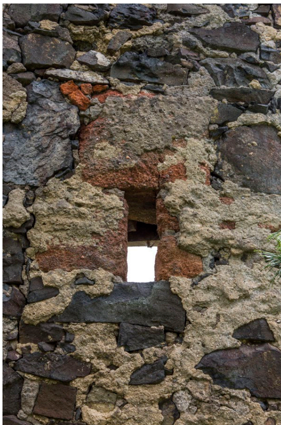
Detail štěrbinového okenního otvoru v ose západního závěru v pohledu od západu. Foto: Marta Pavlíková 2019.
