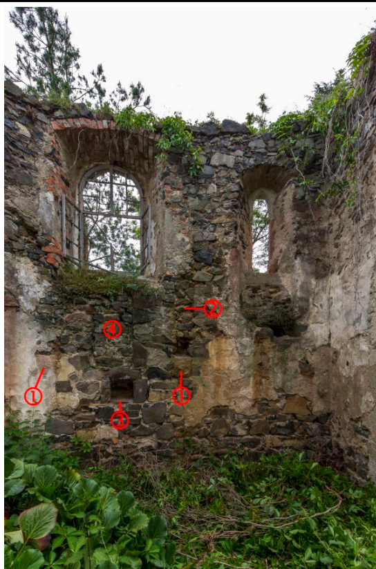
Jižní stěna interiéru presbytáře v pohledu od severu. 1) odsekané klenební konzole, 2) zadržaná kapsa pro osazení žebra klenebního výběhu, 3) prvotní výklenek s výdřevou, 4) zadržaný otvor okenní (?). Foto: Marta Pavlíková 2019.
