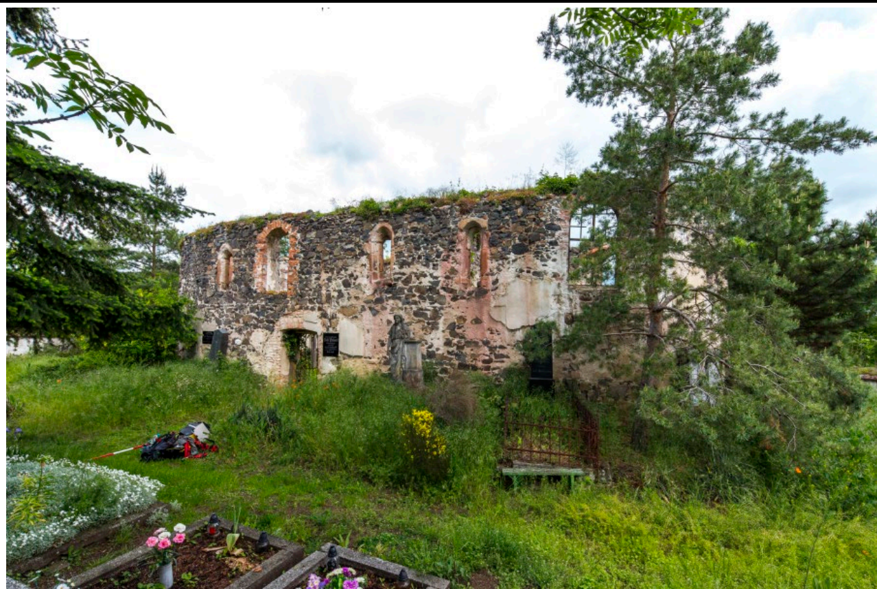
Celkový pohled od jihovýchodu. Foto: Marta Pavlíková 2019.
