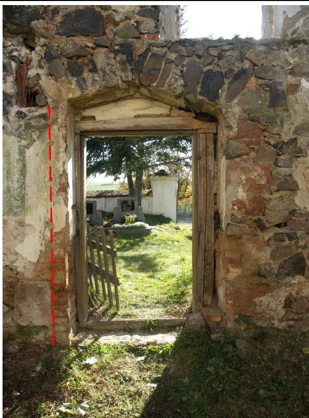
Detail středověké niky jižního vstupu s vyznačenou linií mladší přizdívky. Foto: Jaroslav Skopec 2014.
