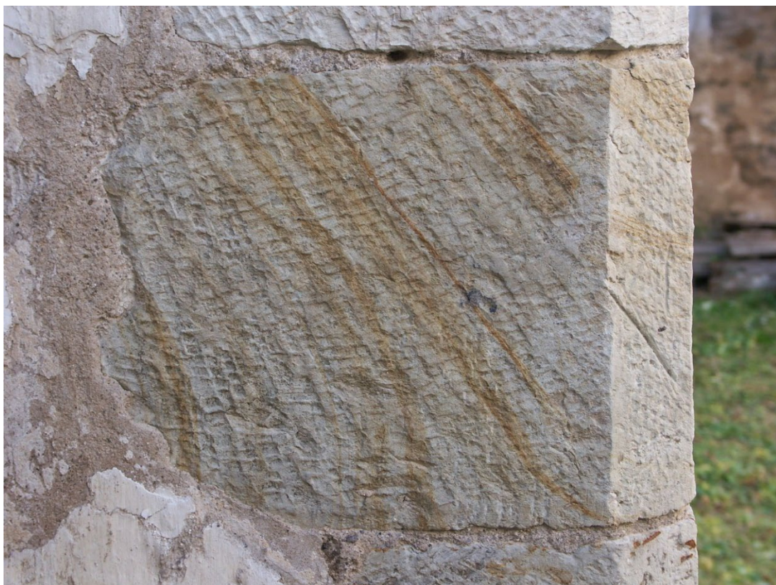
Detail středověkého kamenického opracování kvádrů vítězného oblouku plošinou s plochými zuby. Foto: Jaroslav Skopec 2007.
