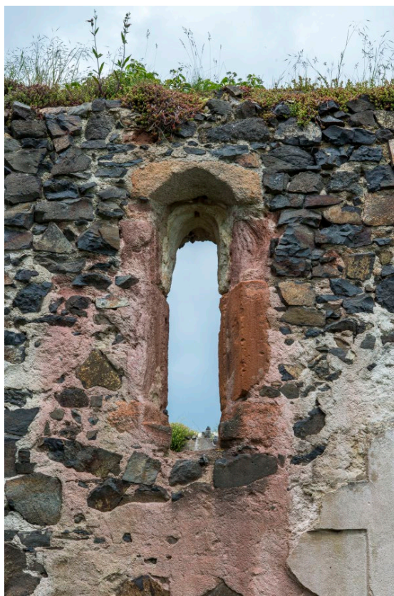
Východní okenní hrotitý otvor jižního průčelí. Foto: Marta Pavlíková 2019.
