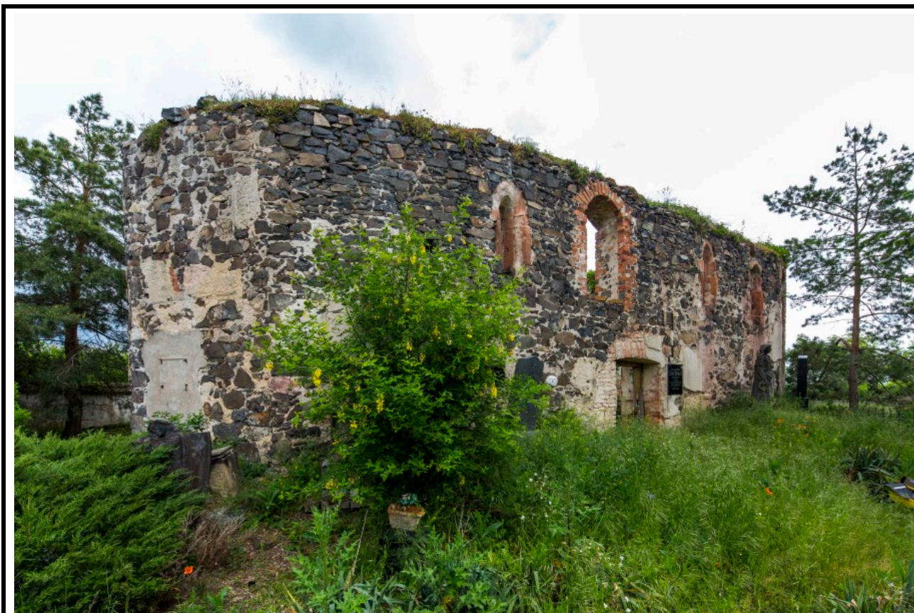
Celkový pohled od jihozápadu. Foto: Marta Pavlíková 2019.
