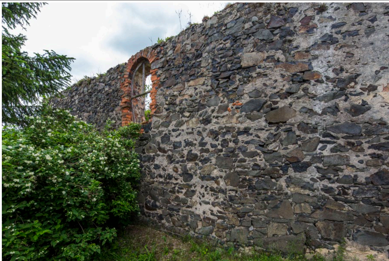
Severní průčelí kostela v pohledu od severozápadu. Foto: Marta Pavlíková 2019.
