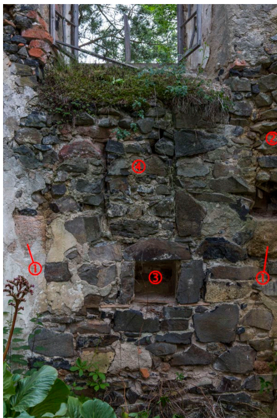
Detail jižní stěny interiéru presbytáře v pohledu od severu. 1) odsekané klenební konzole, 2) zadržaná kapsa pro osazení žebra klenebního výběhu, 3) prvotní výklenek s výdřevou, 4) zadržaný otvor okenní (?).
