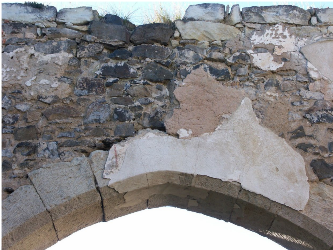
Detail vrcholnice vítězného oblouku v pohledu od východu s patrnou straší omítkovou vrstvou s červenou linkou. Foto: Jaroslav Skopec 2007.
