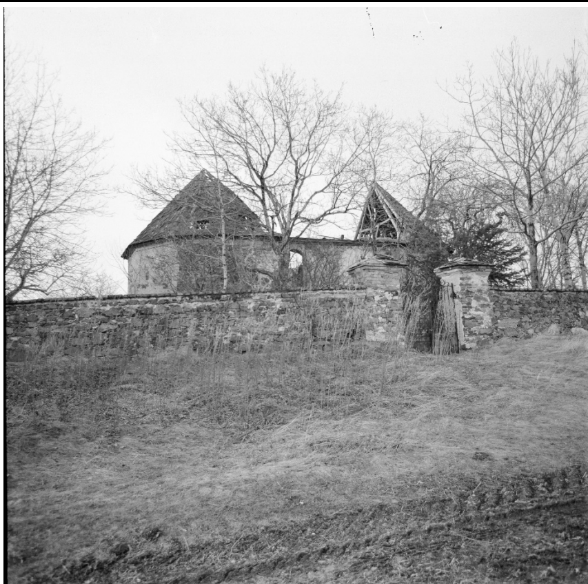
Celkový pohled od jihozápadu. Foto: 1988, sbírka negativů NPÚ ÚOP v Ústí n. L., sign. 94667.
