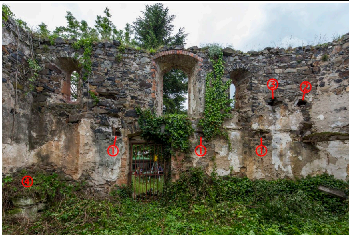
Jižní interiérová stěna lodi v pohledu od severu. 1) kapsy pro zavázání trámů zaniklého jižního ramene kruchty, 2) kapsa pro zavázání trámu zábradlí kruchty a pod ní jeho otisk, 3) kapsa procházející celou tloušťkou zdi vážící se snad k prvotní kruchtě, 4) částečně dochovaná menza bočního oltáře. Foto: Marta Pavlíková 2019.
