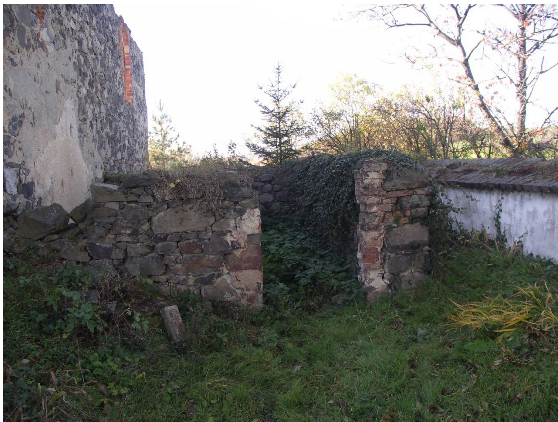
Pohled na márnici od východu. Foto: Marta Pavlíková 2019.
