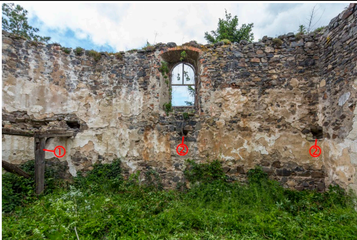
Severní interiérová stěna lodi v pohledu od jihu. 1) torzo trámové konstrukce kruchty dendrochronologicky datované do roku 1608, 2) kapsy pro zavázání trámů zaniklého severního ramene kruchty. Foto: Marta Pavlíková 2019.
