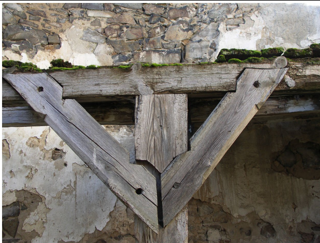
Detail sloupku s pásky západní konstrukce kruchty. Foto: Jaroslav Skopec 2007.
